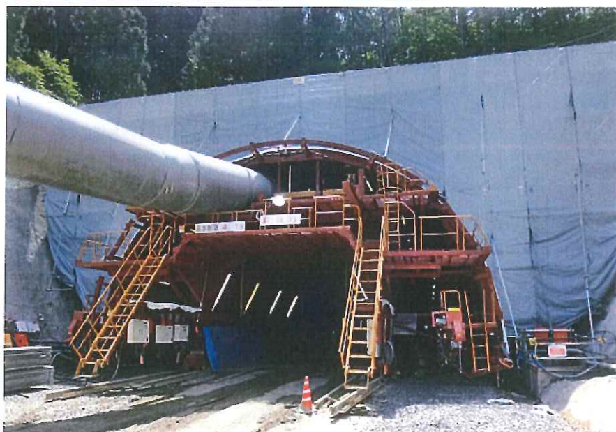
写真-3 移動式型枠
