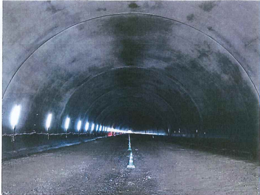
写真-5 覆工コンクリート施工完了
