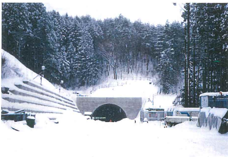
写真-1 冬の庄司淵トンネル
