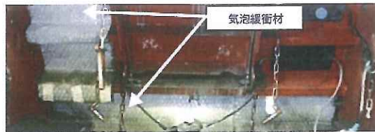
写真-4 型枠への設置状況
